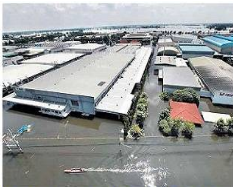
水没のロジャーナ工業団地 団地内をボートが行く
